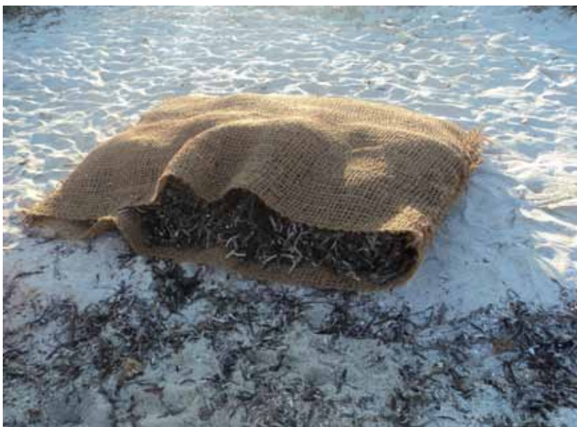
Fig. 1 Riempimento stuoie con Posidonia oceanica
