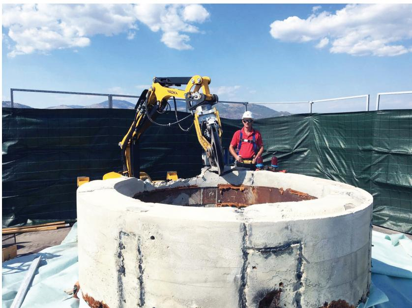
Fig. 3 L'avvio della demolizione del camino della centrale del Garigliano con la tecnica della frantumazione controllata
