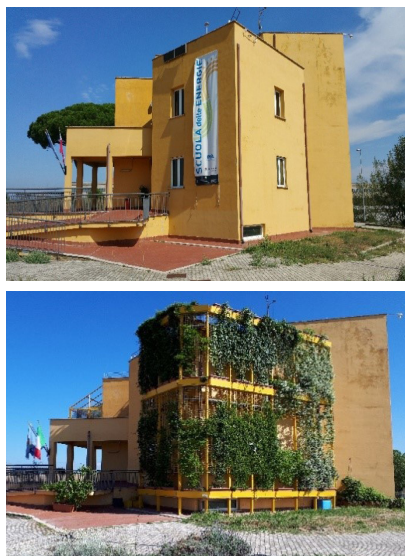
Fig. 2 Edificio verde (Scuola delle Energie). In alto, l'edificio prima dell'installazione di coltre vegetale; in basso, l'edificio con coltre vegetale
