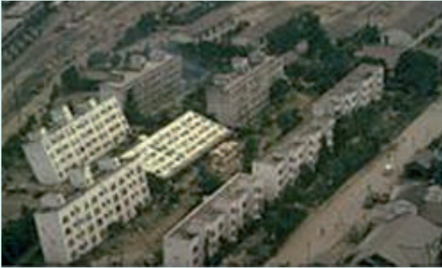
FIGURA 4 Collasso di edifici dovuto a liquefazione a Niigata nel 1964 [2]
