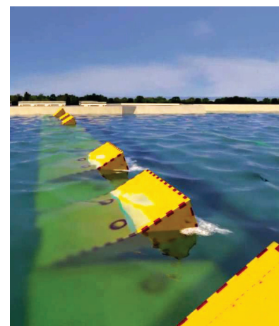
Fig. 3 Paratoie del Mose parzialmente sollevate
