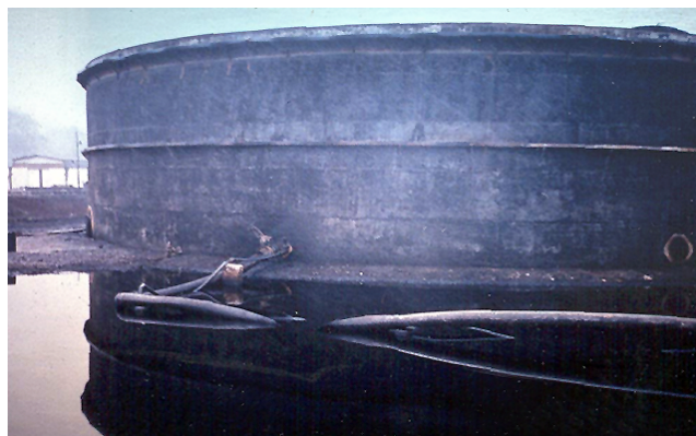
FIGURA 7 Fuoriuscita di liquido dalla sommità di un serbatoio cilindrico semi-interrato a causa dello sloshing
