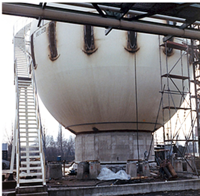
FIGURA 6 Rimozione delle colonne in un serbatoio "Horton" e inserimento dell'isolamento sismico nel basamento
