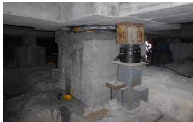
FIGURA 16 Posizionamento dell'isolatore (Edificio Bifamiliare)
