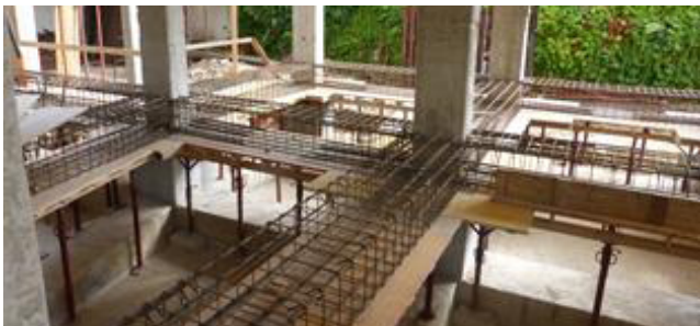
FIGURA 12 Fasi di realizzazione del piano di calpestio collegato ai pilastri esistenti (Edificio Bifamiliare)
