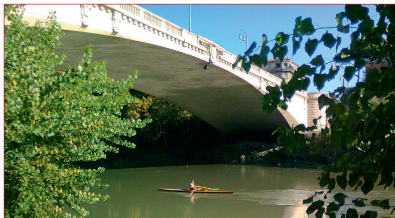
FIGURA 8 Roma: Ponte del Risorgimento
