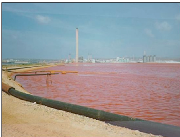
FIGURA 1 Una discarica di "fanghi rossi", scarto di lavorazione della Bauxite per la produzione di Allumina Fonte: ENEA
