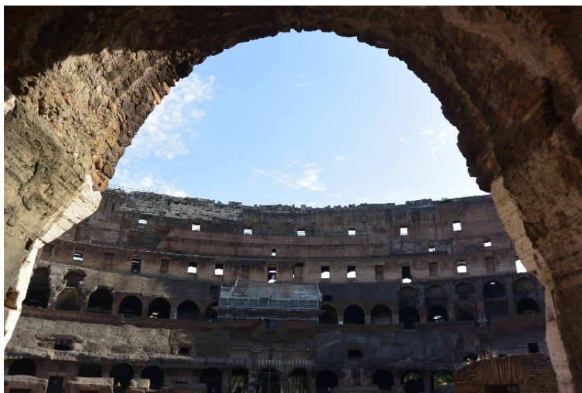
Fig. 1 La parete nord vista dall'interno
