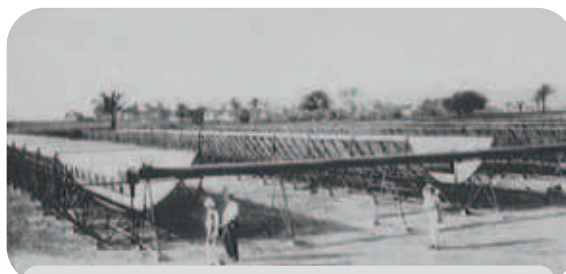
Figura 8 Campi solari con concentratori parabolici lineari, deserto egiziano del Meadi, 1912 Fonte: foto cortesia John Perlin
