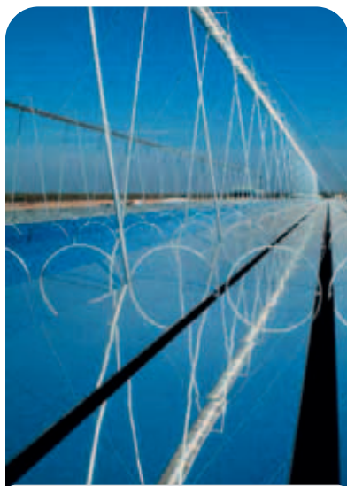
Figura 14 Impianto di Kimberlina di Ausra di 5 MWe, messo in esercizio nel 2008 Fonte: foto cortesia Ausra
