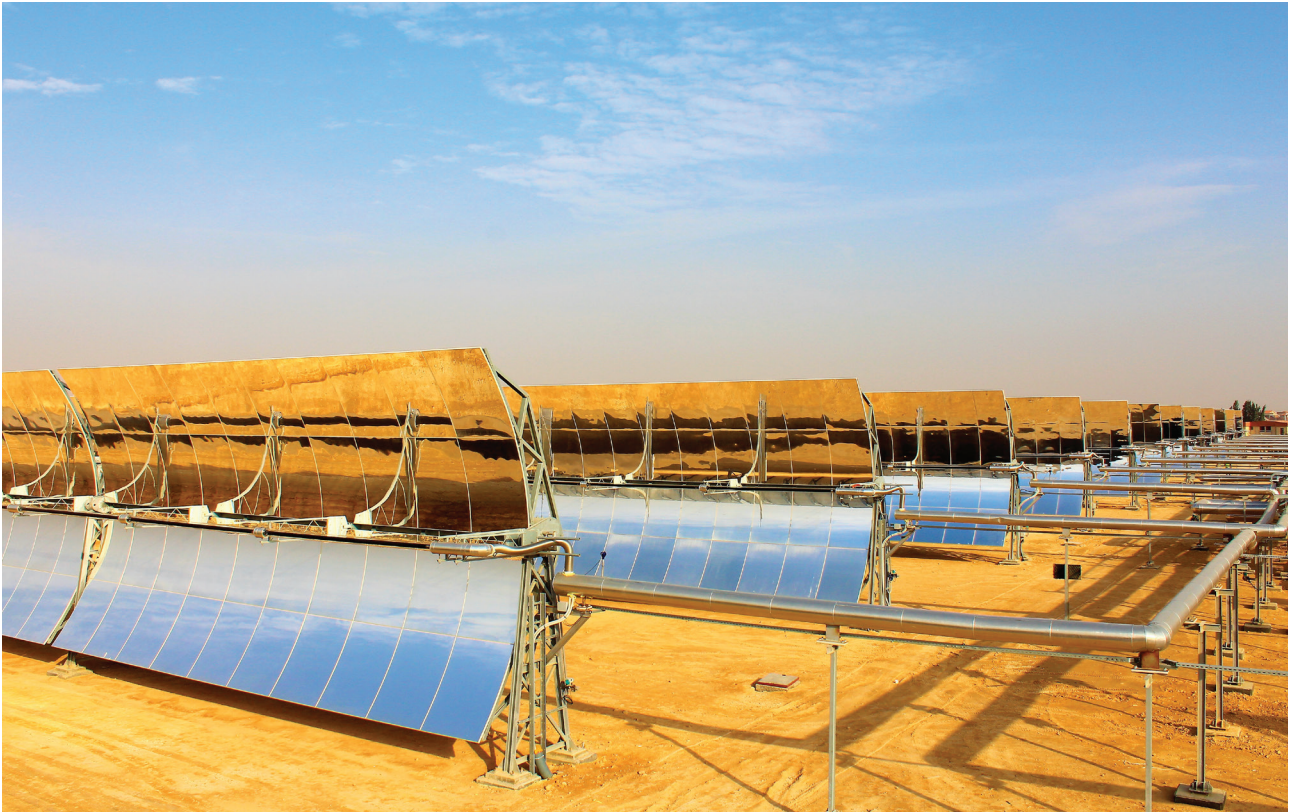
Centrale solare termodinamica realizzata in Egitto nell'ambito del progetto europeo MATS, coordinato dall'ENEA
