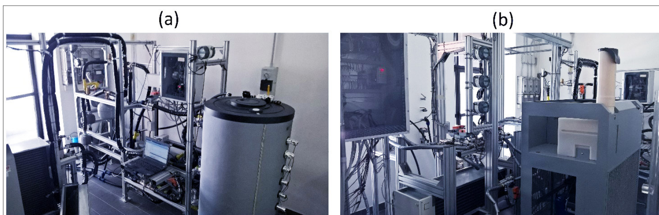
Fig. 1 (a) impianto prove accumulo termico a temperature medio-basse; (b) impianto prove accumulo del freddo
