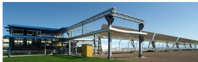
Vista dell'impianto PCS
