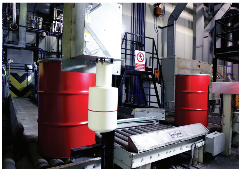
Fig. 3 Impianto di trattamento Nucleco per rifiuti solidi
