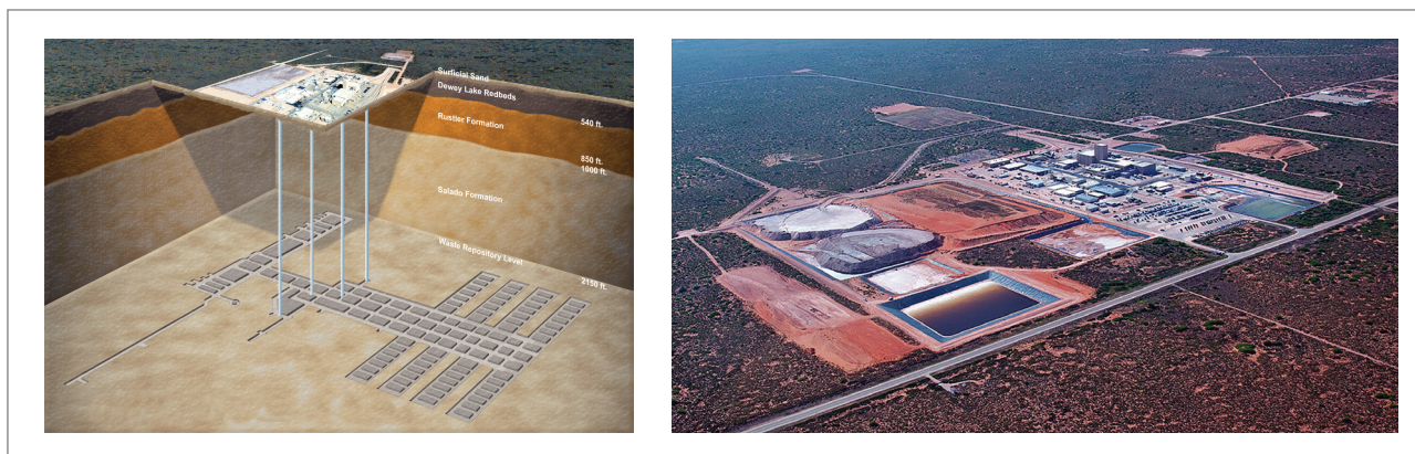
Fig. 3 WIPP (Waste Isolation Pilot Plant), deposito geologico situato nel deserto salino del Nuovo Messico (USA) e gestito dal DOE (Department of Energy)
