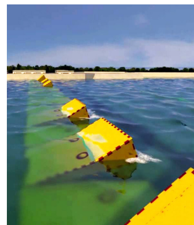
Fig. 3 Paratoie del Mose parzialmente sollevate
