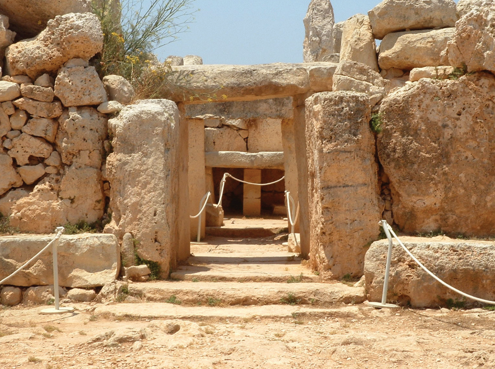
Fig. 1 Effetto sinergico di termoclastismo, erosione eolica e cristallizzazione salina sui monoliti del Tempio di Hagar Qim, Malta
