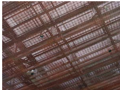
Fig. 8 Herzog & De Meuron. Una seconda pelle interna in lastre di rame microforate funge da filtro per la luce. A parità di foratura (vuoto su pieno) la dimensione del foro e il materiale possono incidere sulla prestazione Fonte: G. Masera
