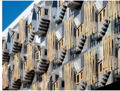
Fig. 5 Enric Miralles, Benedetta Tagliabue - EMBT, Nuovo Parlamento Scozzese di Edimburgo. Le schermature sono discontinue e costituite da un insieme di elementi tubolari in quercia con passo variabile Fonte: G. Masera
