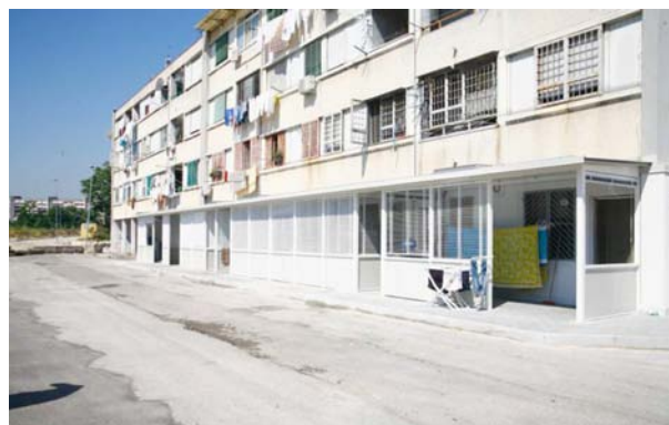
Fig. 2 Frattamaggiore (Napoli): facciata principale dell'edificio prima (a sinistra) e dopo (a destra) l'intervento, dove si nota l'aggiunta della serra solare e i lavori allo scarico fognario. Gli appartamenti coinvolti si trovano al piano terra
