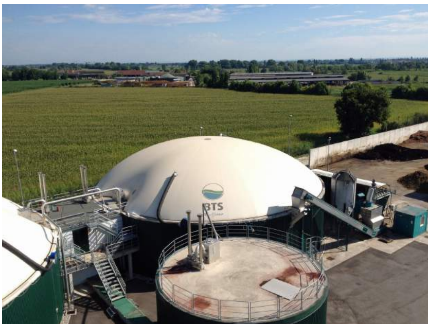
Impianto di biogas da 1 MW che consente di valorizzare gli scarti e i sottoprodotti derivanti dalle attività agricole e dall'allevamento bovino dell'azienda agricola Chiesa (Asolo, Mantova)
