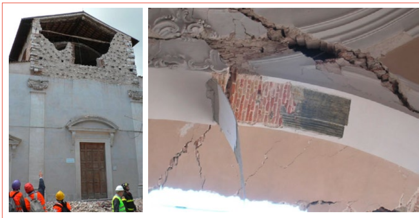
FIGURA 5 A sinistra: Chiesa di San Biagio d'Amiterno (AQ), 2009, terremoto de L'Aquila: crollo parziale della facciata principale della chiesa; la copertura, in occasione di un intervento pre-sisma, è stata irrigidita attraverso l'inserimento di una soletta in cemento armato. A destra: Chiesa di San Marco (AQ), 2009, terremoto de L'Aquila: collasso di un arco causato dalla rotazione rigida dei soprastanti timpani, in cemento armato; nell'immagine è possibile osservare il distacco delle fibre di carbonio applicate all'intradosso dell'arco in occasione di un intervento pre-sisma
