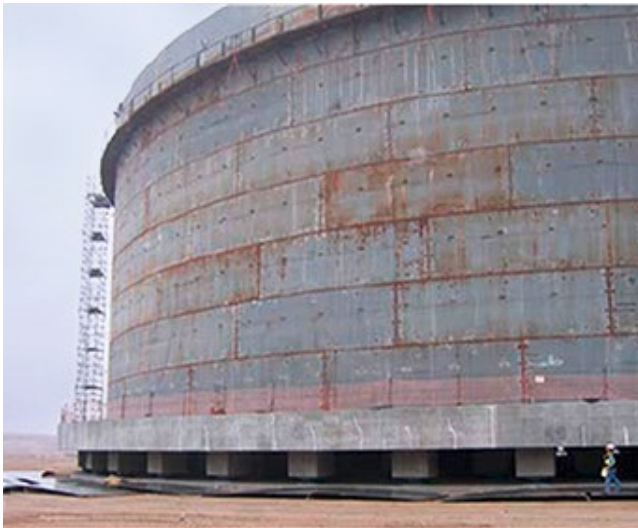
FIGURA 4 Serbatoio LNG a Pampa Melchorita, Perù, isolato con dispositivi a pendolo scorrevole
