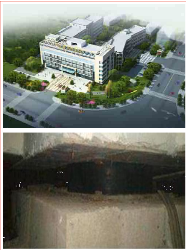
FIGURA 16 Vista (prima del terremoto del 20 aprile 2013) dell'ospedale della contea di Lushan, costituito da un edificio isolato sismicamente (quello frontale, nella foto) e due fondati convenzionalmente (quelli laterali) ed uno degli 83 LRB che costituiscono il sistema d'isolamento dell'edificio isolato Fonte: Zhou et al., 2013; Martelli et al., 2014a
