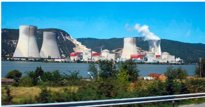
FIGURA 9 I quattro reattori della centrale nucleare di Cruas (Francia), i primi al mondo dotati di isolamento sismico (1983)
