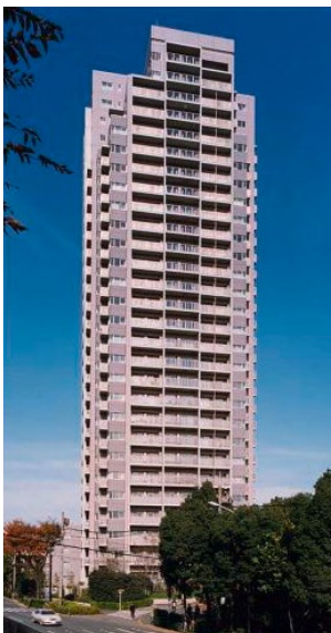
FIGURA 3 Edificio di 87,4 m a Tokyo, isolato nel 2000 con 30 LDRB e 99 dissipatori EPD Fonte: Martelli et al., 2013
