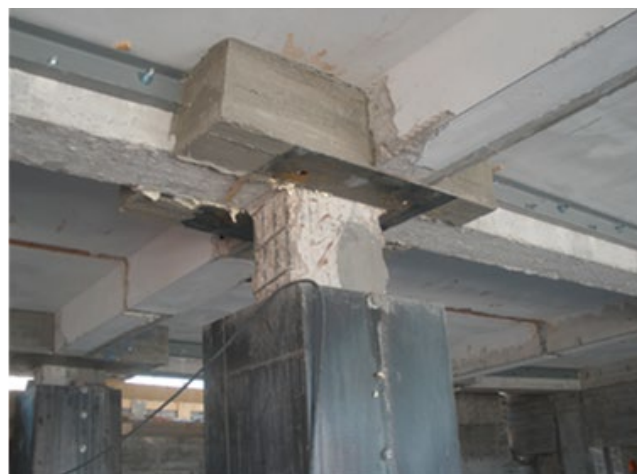
FIGURA 4 Pulvino superiore, è visibile il conccio del vecchio pilastro che dovrà essere tagliato per inserire l'isolatore, mentre sotto è visibile la parte superiore della camicia in acciaio di rinforzo del pilastro (Condominio Pianola)
