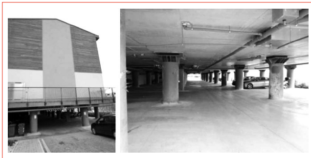
FIGURA 1 Una tipica piattaforma isolata C.A.S.E.
