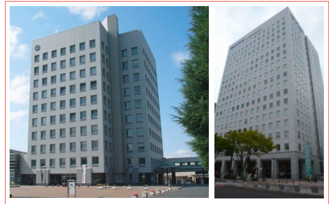
FIGURA 14 La Hachinohe City Hall (10 piani), nei pressi di Sendai, isolata sismicamente con LRB (a sinistra) ed il MT Building (18 piani) a Sendai, isolato sismicamente con RB e SD (a destra); entrambi gli edifici hanno resistito indenni al terremoto di Tohoku del 2011 Fonte: JSSI, 2013; Martelli et al., 2014a
