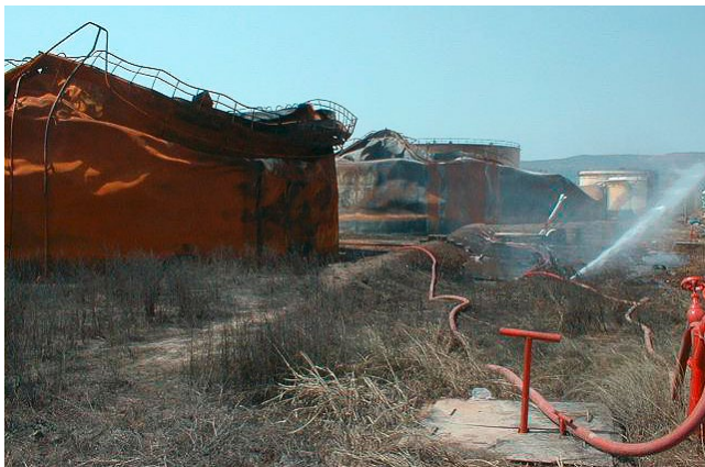
FIGURA 1 Incendio nella raffineria di Tupras, causato dal terremoto della Turchia del 1999
