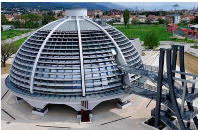
FIGURA 8 L'edificio principale del nuovo Centro della Protezione Civile di Foligno (ex zona sismica 1), isolato con 10 HDRB e collaudato dallo scrivente nel 2011
