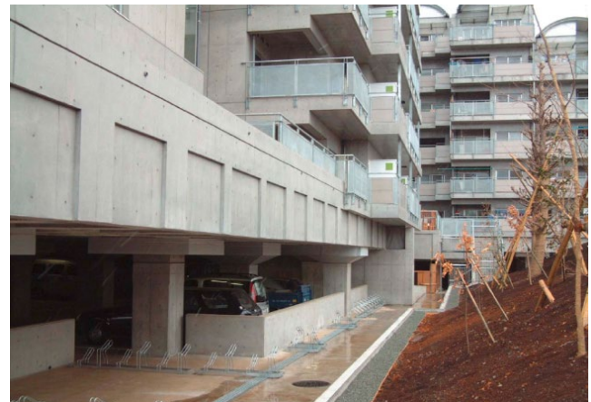
FIGURA 4 Vista laterale del complesso di 21 edifici di 6-14 piani, tutti costruiti su un'unica piastra di "artificial ground" isolata a Sagami-hara (Tokyo) con 48 LRB, 103 SD e 83 BB (Martelli et al., 2014a). Si è trattato della prima applicazione giapponese di "artificial ground"
