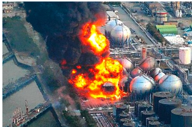
FIGURA 2 Incendio in una raffineria, causato dal terremoto di Tohoku del 2011 (Giappone)
