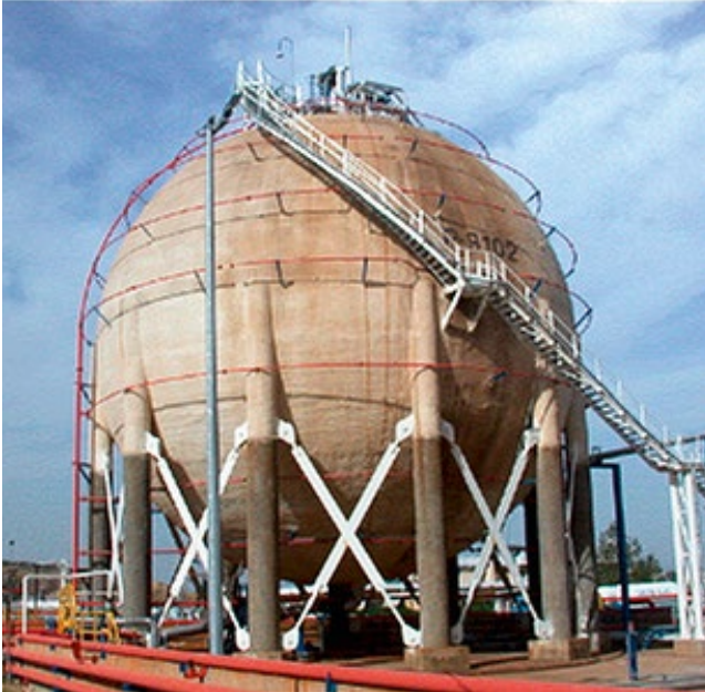
FIGURA 5 Retrofit con controventi su di un serbatoio sferico nella raffineria di Aspropirgos (Grecia)
