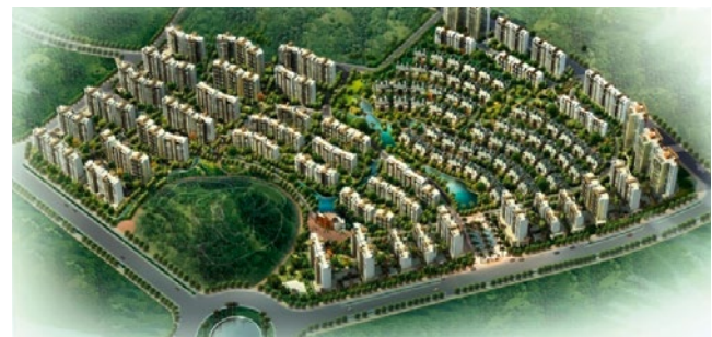
FIGURA 5 Uno dei complessi di edifici residenziali isolati sismicamente nella R.P. Cinese, realizzato nella parte sudoccidentale del paese e costituito da 82 edifici di 4-16 piani tutti isolati singolarmente (area totale = 210.000 m 2 ); molti edifici isolati cinesi sono residenziali e, fra questi, numerosi sono quelli in muratura, anche di notevole altezza Fonte: Martelli et al., 2014a
