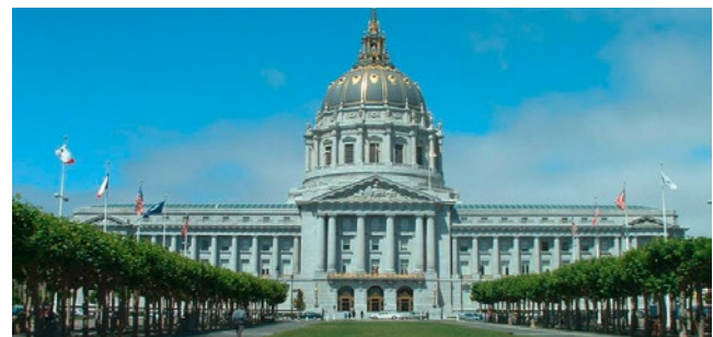
FIGURA 6 La City Hall di San Francisco (California, USA), distrutta dal sisma del 1906, ricostruita nel 1912, nuovamente danneggiata dal terremoto di Loma Prieta del 1989 ed adeguata nel 2000 con 530 LRB e 62 SD Fonte: Martelli et al., 2013
