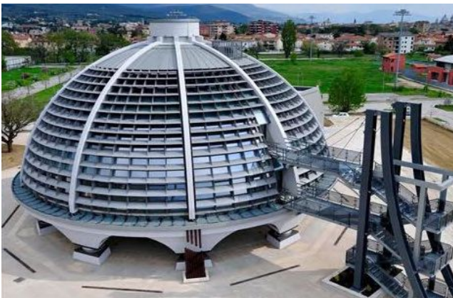
FIGURA 8 L'edificio principale del nuovo Centro della Protezione Civile di Foligno (ex zona sismica 1), isolato con 10 HDRB e collaudato dallo scrivente nel 2011
