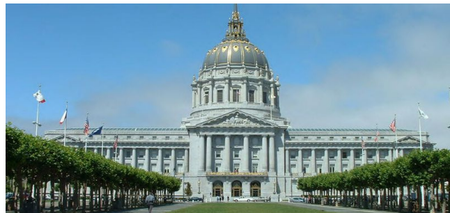
FIGURA 6 La City Hall di San Francisco (California, USA), distrutta dal sisma del 1906, ricostruita nel 1912, nuovamente danneggiata dal terremoto di Loma Prieta del 1989 ed adeguata nel 2000 con 530 LRB e 62 SD Fonte: Martelli et al., 2013
