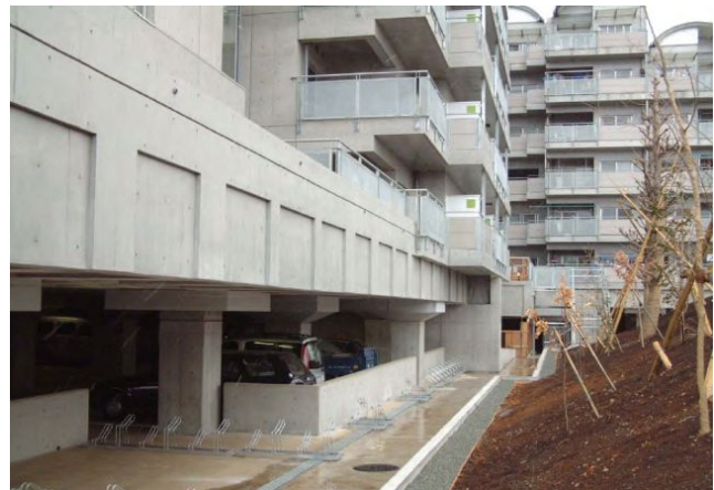
FIGURA 4 Vista laterale del complesso di 21 edifici di 6-14 piani, tutti costruiti su un'unica piastra di "artificial ground" isolata a Sagami-hara (Tokyo) con 48 LRB, 103 SD e 83 BB (Martelli et al., 2014a). Si è trattato della prima applicazione giapponese di "artificial ground"
