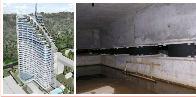
FIGURA 7 L'Hayat (Sea Plaza) Hotel, un edificio di 28-piani in c.a. isolato sismicamente (con 2 piani interrati), alto 93,6 m e con area totale di 40.000 m 2 , costruito a Sochi (Federazione Russa) ed alcuni dei 193 HDRB, fabbricati in Italia, che costituiscono il sistema di isolamento Fonte: Martelli et al., 2014a
