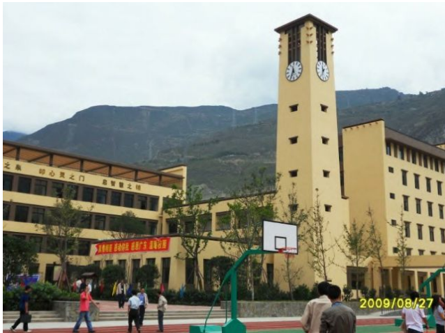
FIGURA 19 Scuola isolata sismicamente a Lushan, rimasta indenne dopo il terremoto del 2013 Fonte: Zhou et al., 2013
