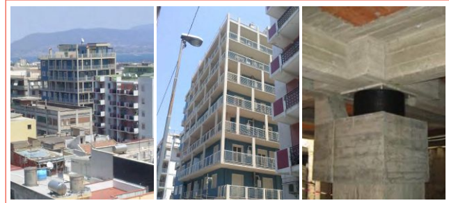
FIGURA 11 Esempio di recente applicazione italiana dell'isolamento sismico a scopo preventivo: il nuovo edificio di 7 piani fuori terra di Via Spadafora a Messina (ex zona sismica 1), protetto da 22 LRB e 2 SD installati alla sommità del cantinato (progetto del sistema d'isolamento dei soci del GLIS Ingg. Manlio Marino ed Alberto Dusi; certificato di collaudo in corso d'opera rilasciato dallo scrivente e dall'Ing. Giovanni Caminiti di Messina a luglio 2014)
