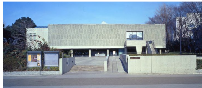
FIGURA 15 Il National Western Art (Le Corbusier) Museum (4 piani) di Tokyo, adeguato con l'inserimento di HDRB in soффondazione nel 1999; durante il terremoto di Tohoku del 2011 l'isolamento ridusse i valori della PGA nelle due direzioni orizzontali da 0,19 e 0,27 g a 0,08 e 0,10 g alla sommità Fonte: JSSI, 2013; Martelli et al., 2014a
