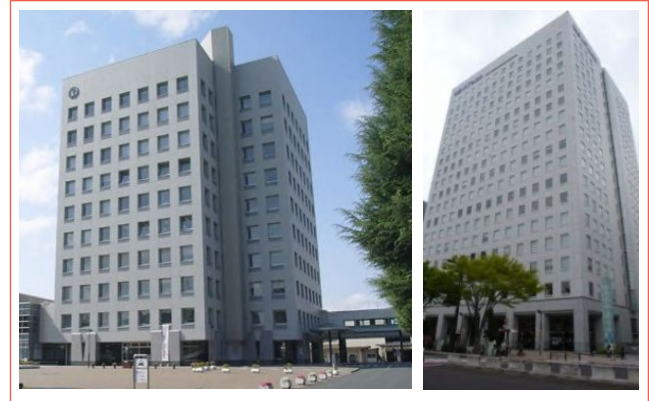
FIGURA 14 La Hachinohe City Hall (10 piani), nei pressi di Sendai, isolata sismicamente con LRB (a sinistra) ed il MT Building (18 piani) a Sendai, isolato sismicamente con RB e SD (a destra); entrambi gli edifici hanno resistito indenni al terremoto di Tohoku del 2011 Fonte: JSSI, 2013; Martelli et al., 2014a
