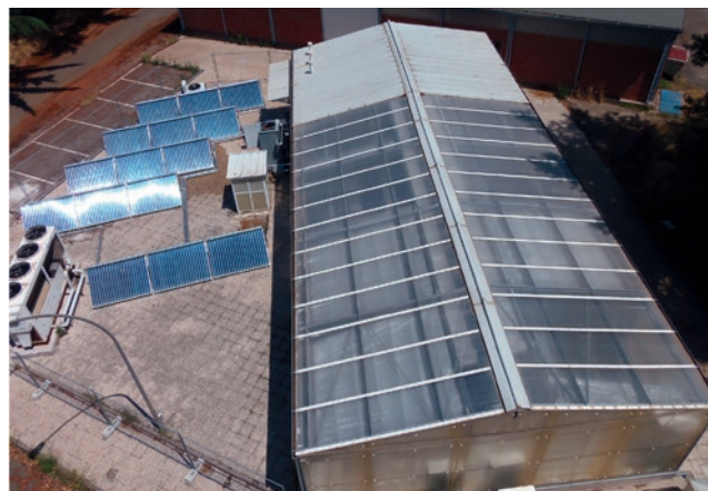
Serra sperimentale a contenimento, integrata da un impianto di raffrescamento solare, presso il Centro Ricerche Casaccia dell'ENEA
