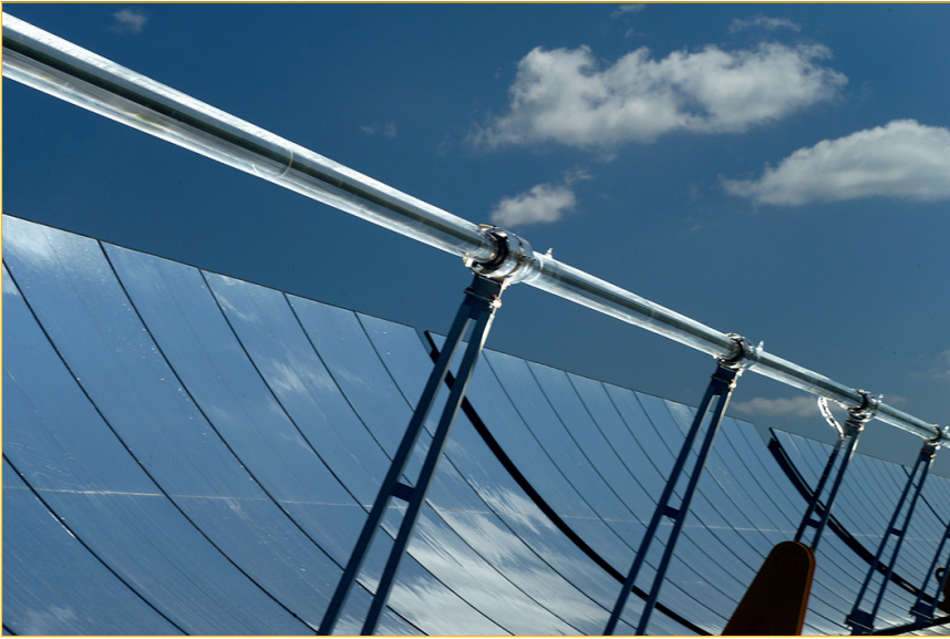
FIGURA 1 Sistema ottico costituito da specchi di forma parabolica che riflettono la radiazione solare sulla superficie del tubo ricevitore Fonte: ENEA
