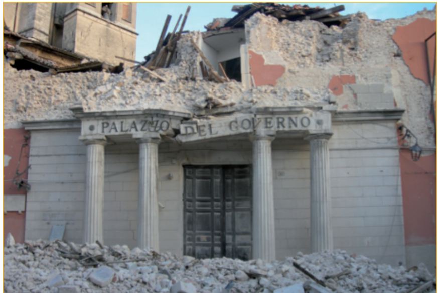
FIGURA 4 Edificio strategico parzialmente collassato durante il sisma dell'Aquila del 2009
