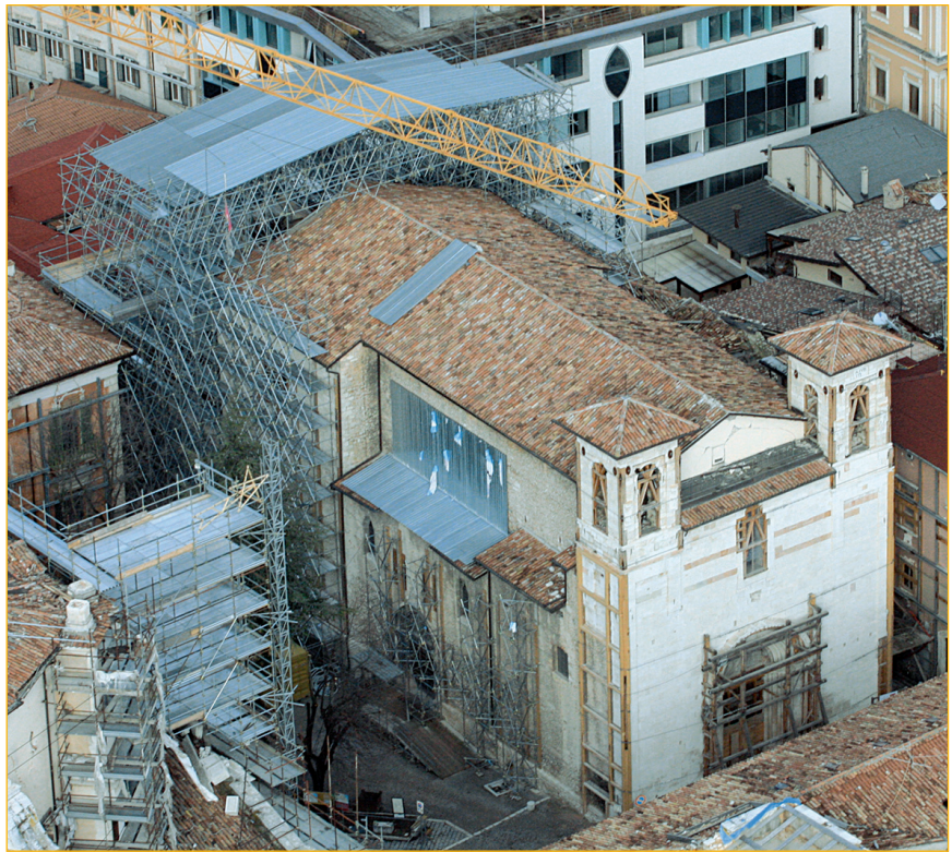
FIGURA 1 L'Aquila: messa in sicurezza della Chiesa di San Marco
