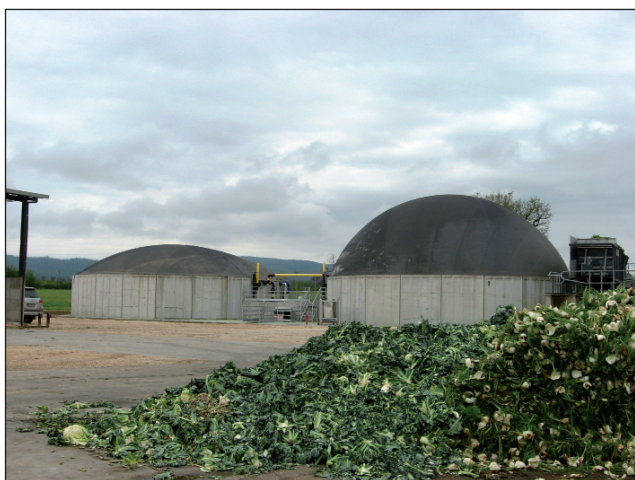
FIGURA 1 Impianto per la produzione di biogas da 500 kW in un'azienda agro-zootecnica nei pressi di Sutri (VT), aprile 2011
