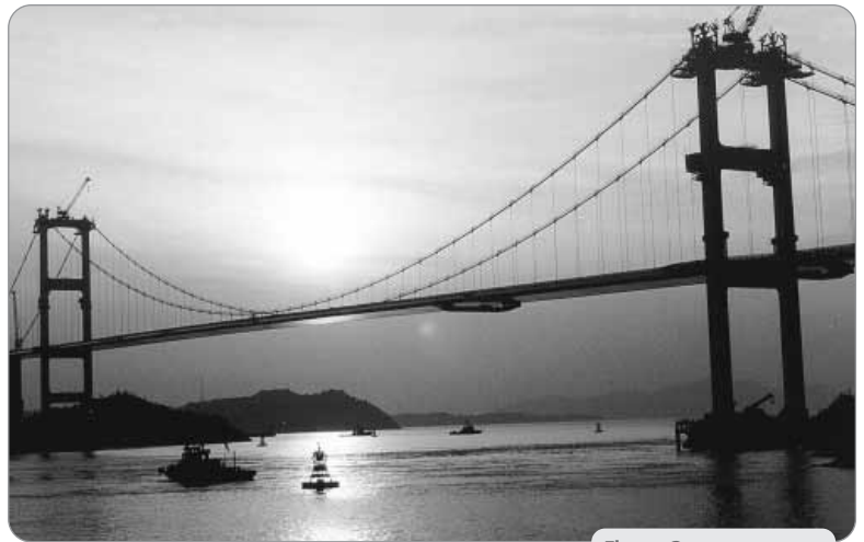
Figura 3 Il Kurushima Bridge (durante la costruzione) fa parte delle meraviglie dell'ingegneria che collegano le isole di Honshu e Shikoku in Giappone
