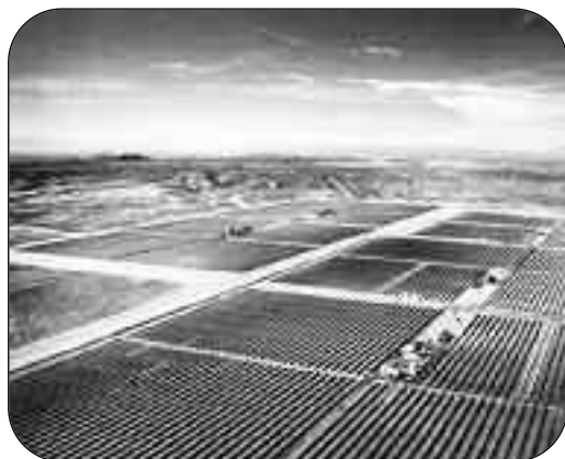
Figura 7 Impianti SEGS presso Kramer Junction
