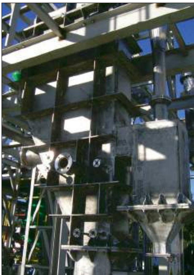
FIGURA 11 Il gassificatore a letto fluido in fase di montaggio Fonte: ENEA
