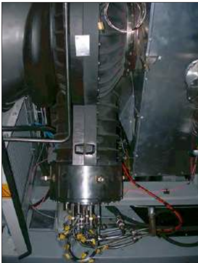
FIGURE 14 Il bruciatore ARI100 T2 montato sulla microturbina Turbec T100 Power Fonte: ENEA
