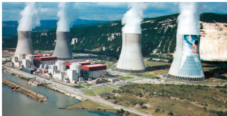
FIGURA 3 Le 4 unità PWR di Cruas, Francia, dotate di isolamento sismico Fonte: http://www.icjt.org/
