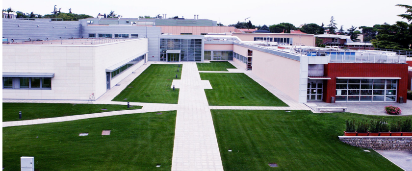
Impermeabilizzazione di tetti di edifici industriali a Castel Guelfo di Bologna
