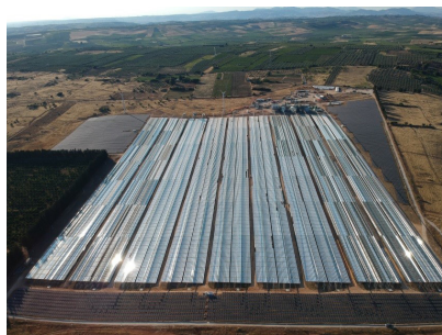
Fig. 4 Impianto commerciale CSP in fase di realizzazione presso Partanna (Trapani)
