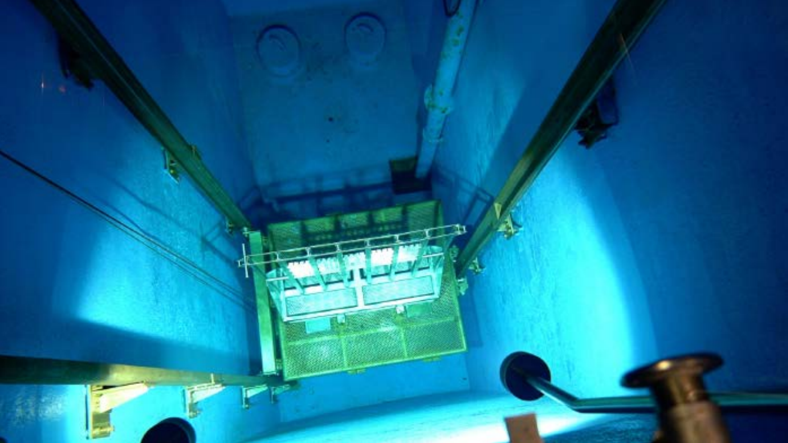
Fig. 1 Nell'immagine è visibile la piscina dell'Impianto Calliope e, sul fondo, la rastrelliera portasorgenti con le 25 barre di Cobalto-60. La luce azzurra è prodotta dalla ionizzazione dell'acqua vicino alle sorgenti (effetto Cherenkov)
