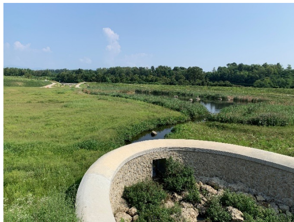
La vasca 1 con l'area umida permanente ed il manufatto di collegamento con la vasca 2. Sullo sfondo l'opera di presa sul torrente Lura.
