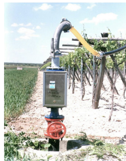
Figura 3 – Idranti automatici con schede elettroniche.
