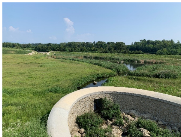
La vasca 1 con l'area umida permanente ed il manufatto di collegamento con la vasca 2. Sullo sfondo l'opera di presa sul torrente Lura.
