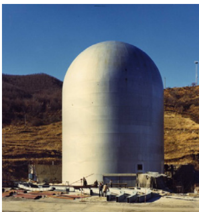
Contenimento del Reattore PEC in fase di installazione
